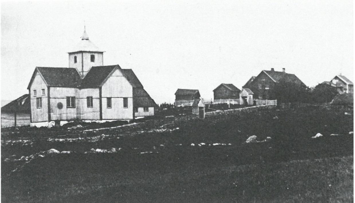
Figur 6 Hov kirke fra 1781 slik den så ut før moderniseringen i 1871. De overbygde porthusene i kirkegårdsmuren fra 1781 ble revet ved moderniseringen i 1871. Bygningene er en del av klyngetunet i Hov med Oppistuen lengst til høyre på bildet. Fra jubileumsboka.
