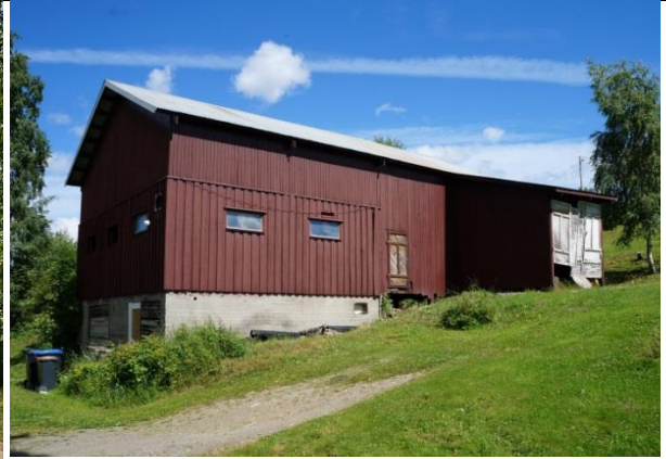
Neraker, låve med fjøs fra 1960-tallet (ikke opprinnelig bygningsmasse på småbruket). Foto Dag Lindbråten
