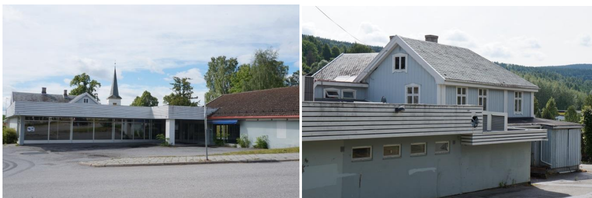
Figur 28 Fladsrud før saneringen av bygningsmassen høsten 2015.
