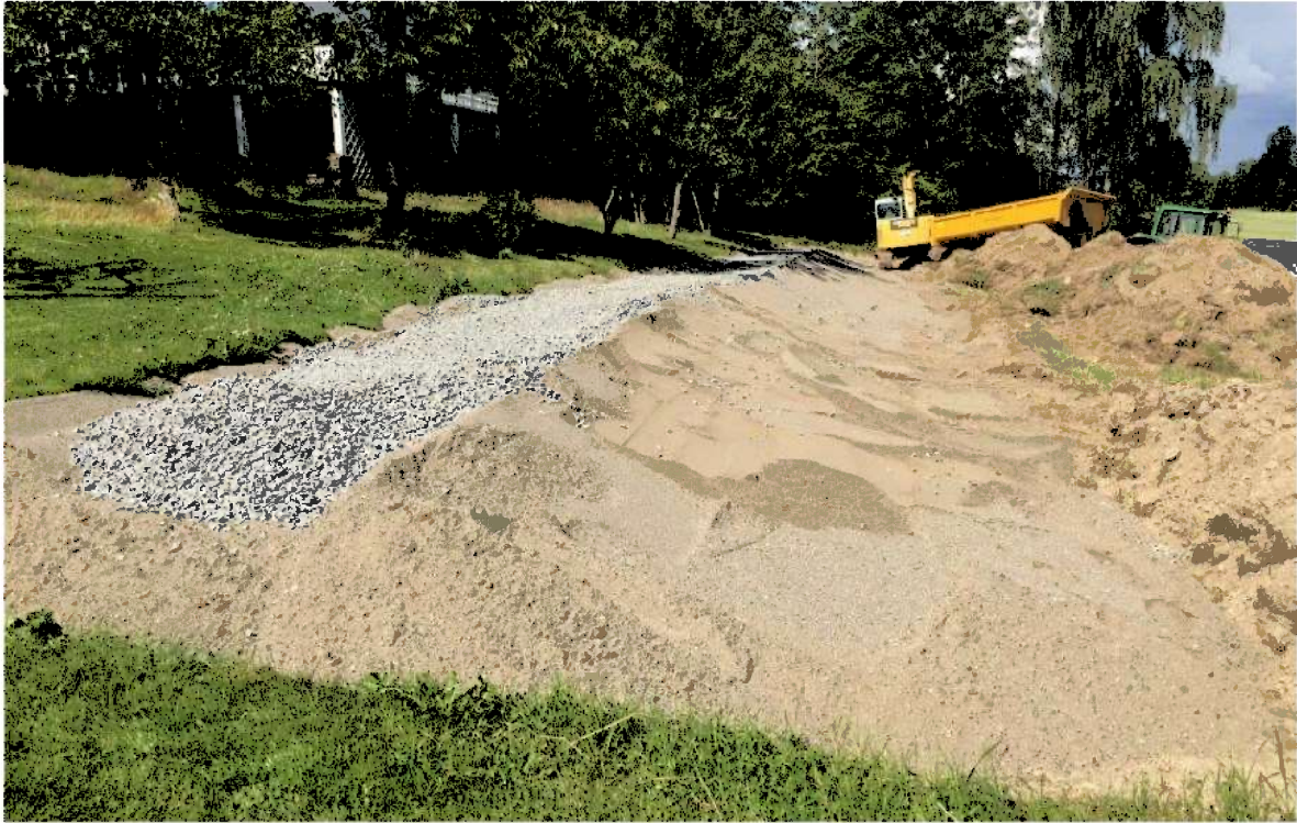
Figur 1: Bilde av oppbygd infiltrasjonsfilter med tilkjørt sand og pukk, delvis etablerte sanddrygger og drenerende sandmasser lagt ut nedstrøms infiltrasjonsflaten
