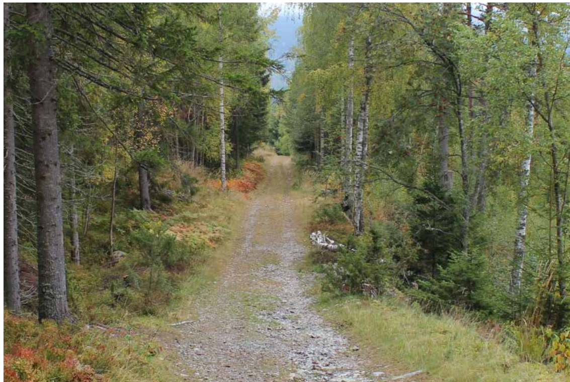
Bergenske hovedveg over Hornskleiva ble bygget i perioden 1801 - 1811. Veggen mellom Christiania og Bergen er bygget etter det franske prinsipp med lange rette strekk og markerte knekkpunkter slik bildet viser. Bevarte "fossile" deler viser at det franske prinsipp er konsekvent gjennom Land. Veggen over Hornskleiva er ca 6 meter bred.
