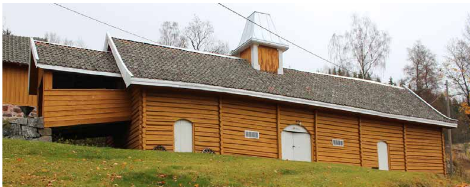
Våningshus og enhetslåver er dominerende bygninger på gårdstunene. Sidebygningene i firekanttunene fremgår av faktarkene, men dette er vanligvis stabbur, bryggerhus og vognskjul. Her et eksempel på et vognskjul fra 1862 på Midtberg.
