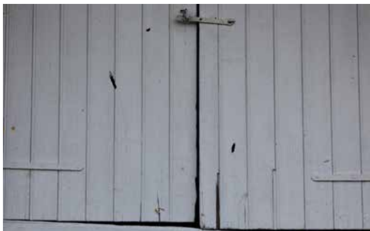
Detalj av låvedøra på Skoglund med spor etter tyske granatsplinter fra trefningen på Haga 22. april 1940. Låven er full av hull.
