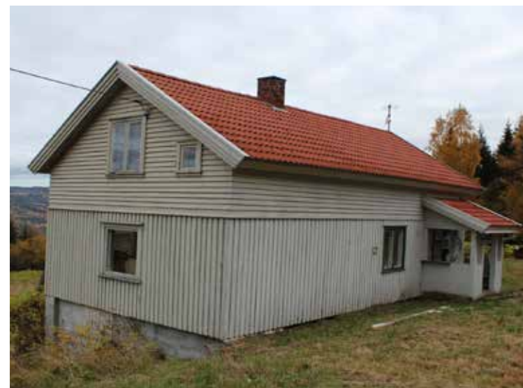
Våningshuset med opprinnelige tømmerkasse til og med kjøkenvinduet på langfasaden.
