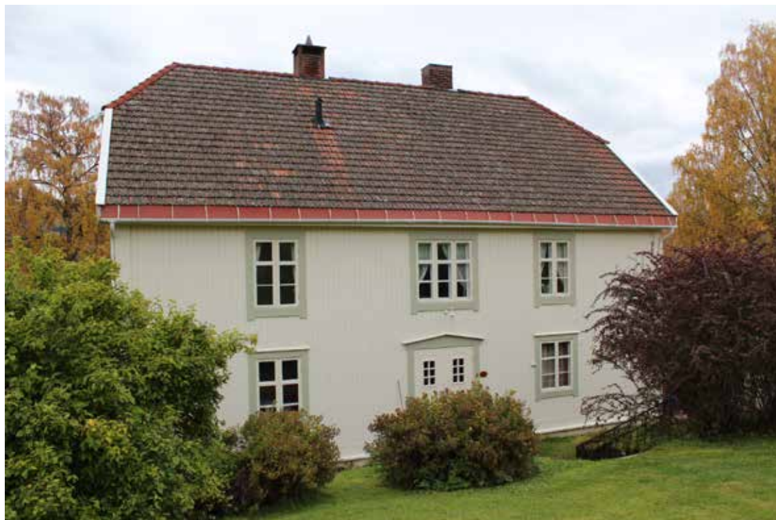
Telefonsentralen i Ringelia lå i denne bygningen fra 1930 på Sarastuen. Utstyret er fjernet, men sporene etter monteringen er fortsatt bevart.
