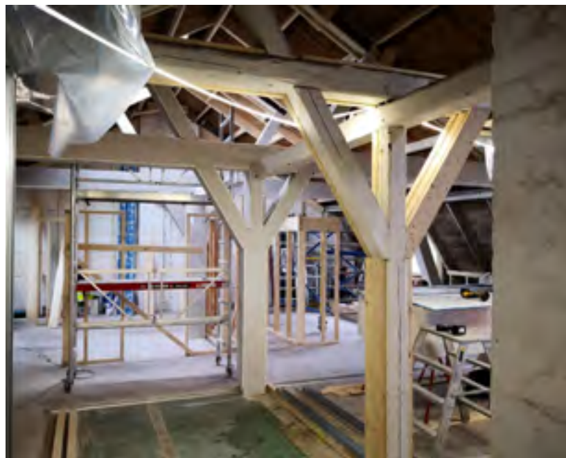
Mellomveien 18 Den tidligere sjokoladefabrikken i Trondheim sentrum har blitt til 53 leiligheter. Sammenlignet med nybygg på samme tid har prosjektkostnadene vært lave, samtidig som man har møtt både tekniske og antikvariske krav. Øverst: bygningen i dag. Til venstre: samme sted før renovering. Under: reparasjon av takkonstruksjon. Foto: Trym bygg AS
