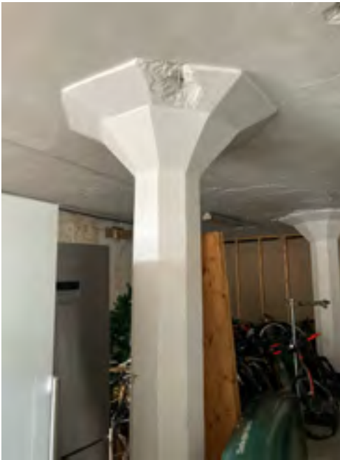
Solid betongbygg med søyler/dekker som gir rom for fleksibilitet.
