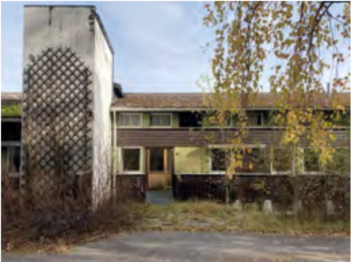
Bygningen har gode forbindelser til bakkeplan både i overetasjen og underetasjen.
