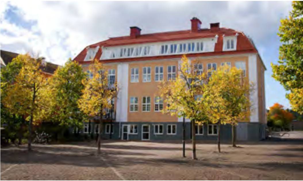
Hultsfred skole I Hultsfred sentrum har den gamle skolen fått nytt liv som eldreboliger. Den er totalrenovert av Statens Bostadsomvandling og fått balkonger og heis. Foto: SBO
