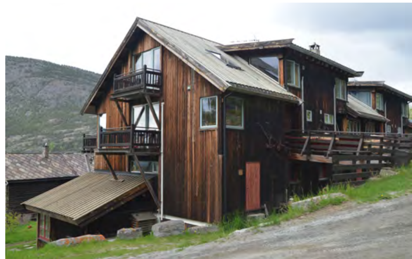
Låven i Lom I Lom sentrum har en tidligere låve blitt til boliger for utleie. Peter Butenschøn var arkitekt i transformasjonen, rett ved Steinsenteret. Foto: Oda Solberg
