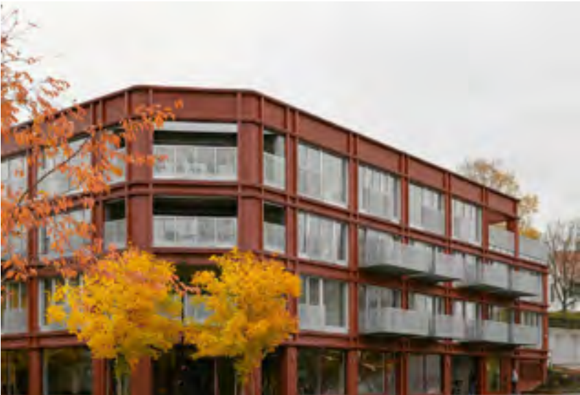
Sentrumsgården Transformasjon av Sentrumsgården i Heggedal er tegnet av Vignæs + Kosberg ++ Arkitekter. Bygget fra 80-tallet ble brukt til kontor og næring, og har nå blitt 25 leiligheter. Fasaden har blitt erstattet med større vinduer og trekledning. Foto: Magnus Åmand Lindquist
