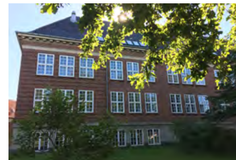
Rudkøbing gamle skole Den tidligere skolen i Rudkøbing har blitt 21 almene seniorboliger (en boform med rimelig leie). Prosjektet har bevart store deler av fasaden slik den var som skole. Den gamle vaktmesterboligen har blitt beboernes felleshus og gjesteovernatting. Foto: C & W Arkitekter A/S
