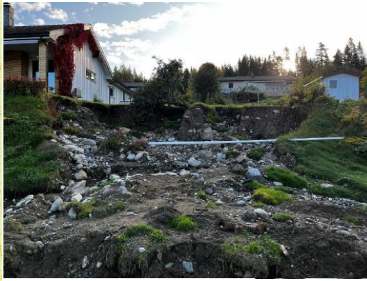
Bilde: Skade på tomt
