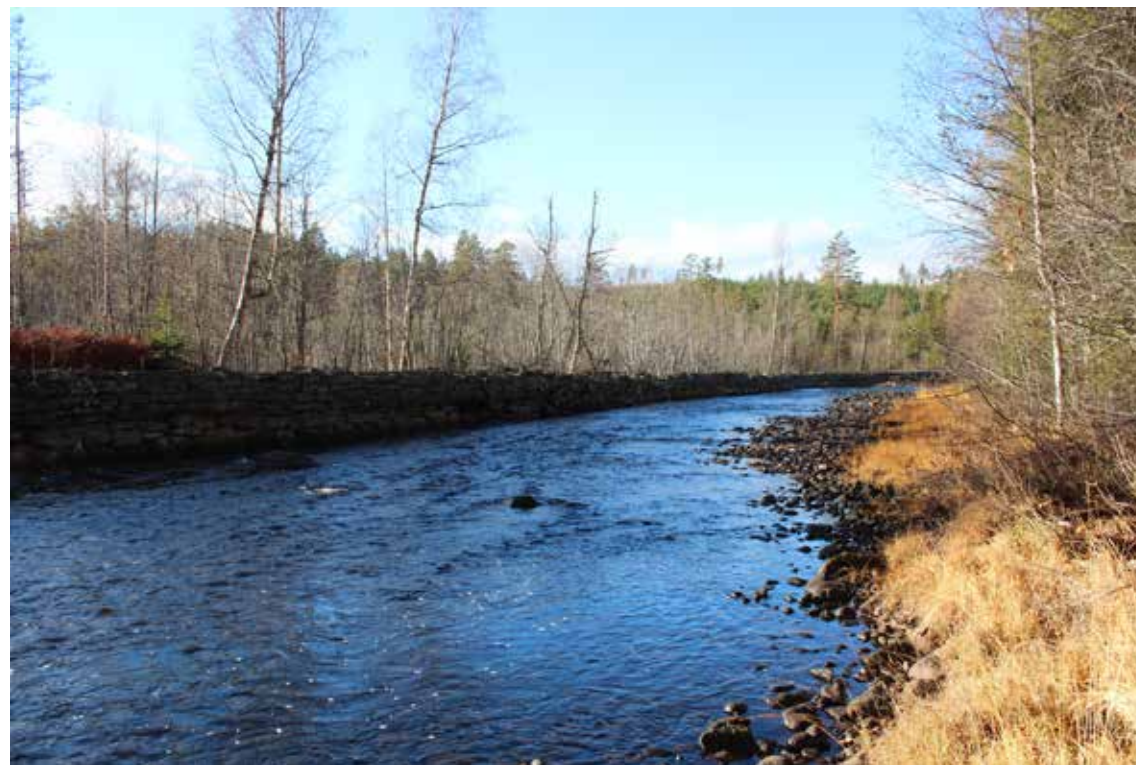
En del av "Kilometerdammen" ved Nyseter. Flotte steinarbeider, slik som denne skådammen karakteriserer Lomsdalselva som brøtningselv i dag.
