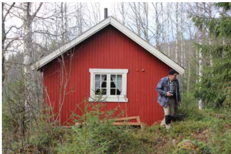
Damhytta på Askvikfløyta med spor etter innlagt telefon. Brøtningen i Sandungselva/Lygna ble opprinnelig varslet med ei dynamittsalve, noen sier også et børseskudd. Varslingen ble vesentlig forbedret med telefonisk forbindelse via telefonsentralen på Sarastuen.
