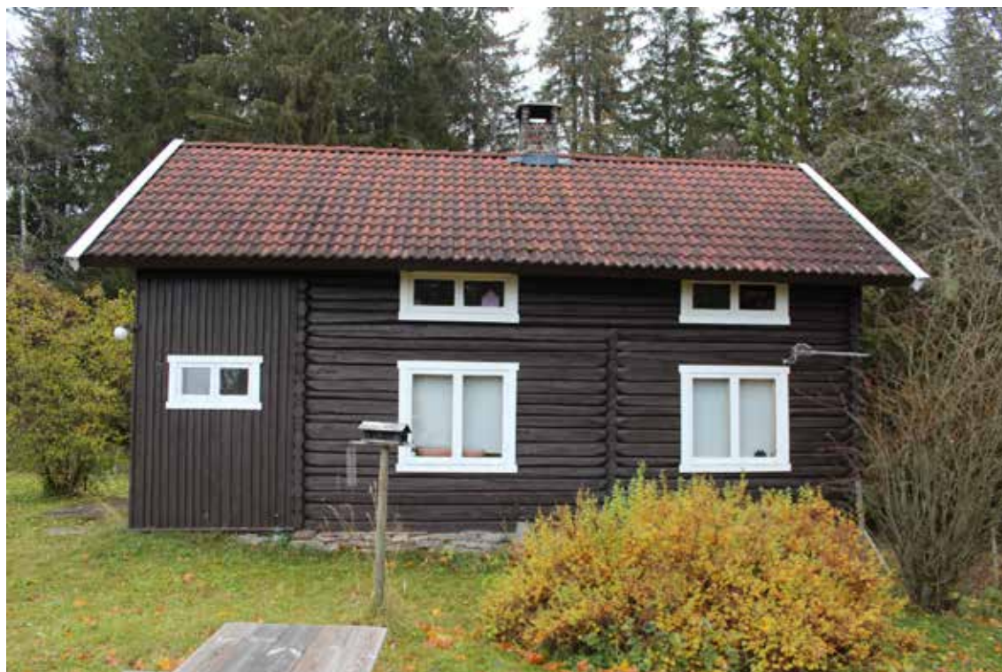
Våningshus fra 1800-tallet med opprinnelig preg. Reisverksdelen i nord er tilbygget på 50-tallet.
