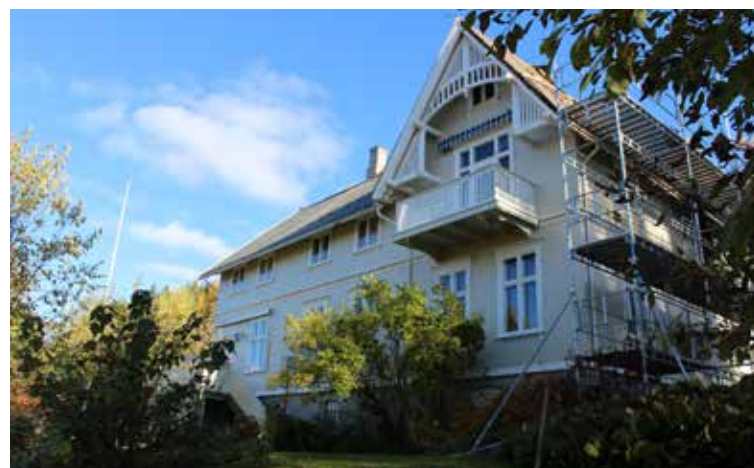
Arbeidervilla i "Bølgeblikkbyen" fra tidlig 1930-tall (over) og direktørvilla under restaurering (under).
