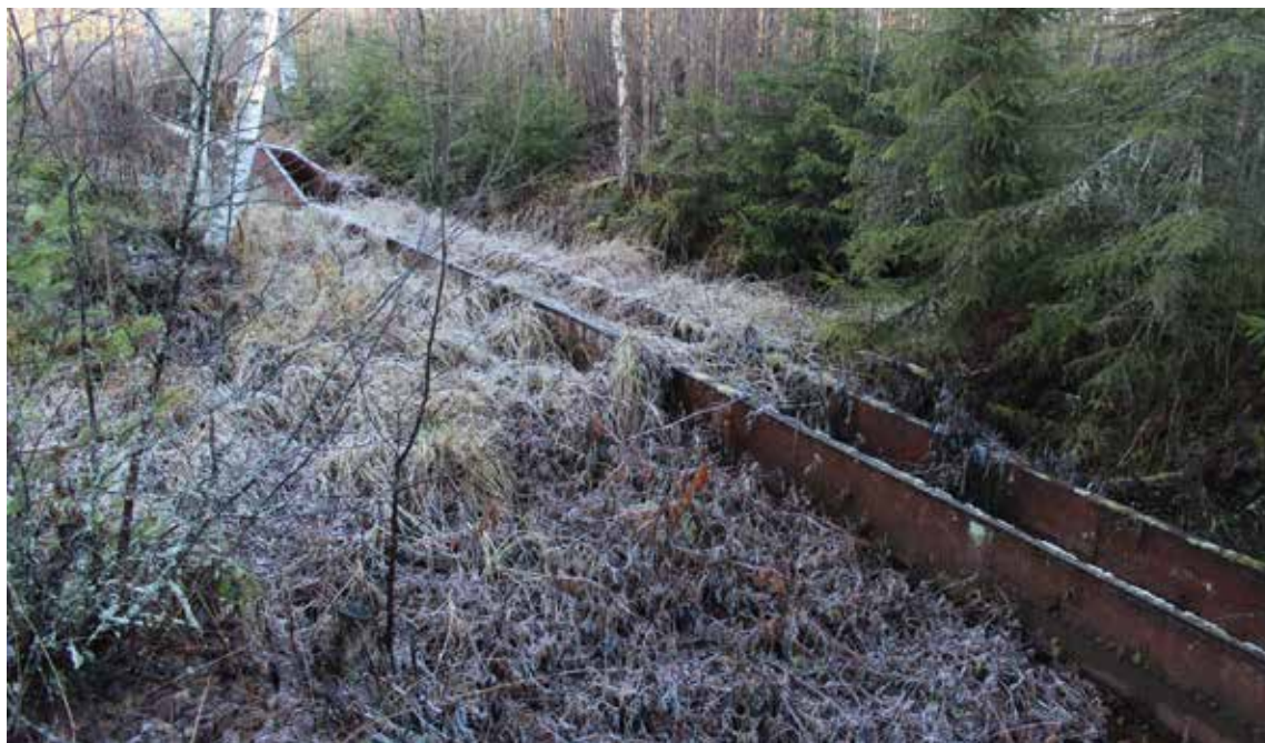
Tømmerrenna fra 1901 er relativt godt bevart mellom Kanaldammen og Linneruddammen.
