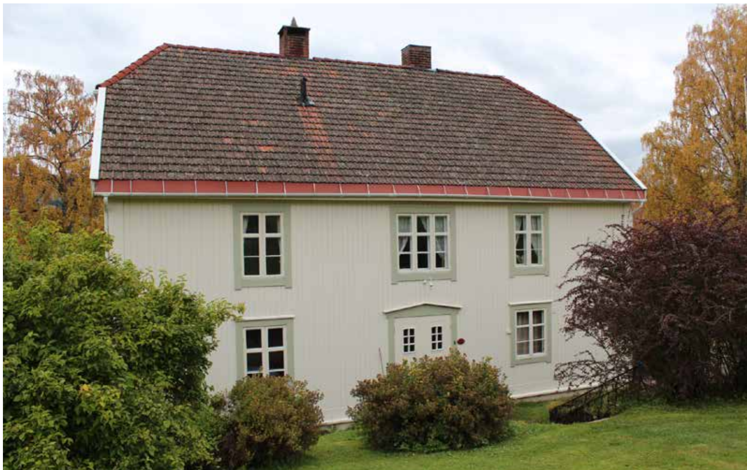
Telefonsentralen i Ringelia lå i denne bygningen fra 1930 på Sarastuen. Utstyret er fjernet, men sporene etter monteringen er fortsatt bevart.
