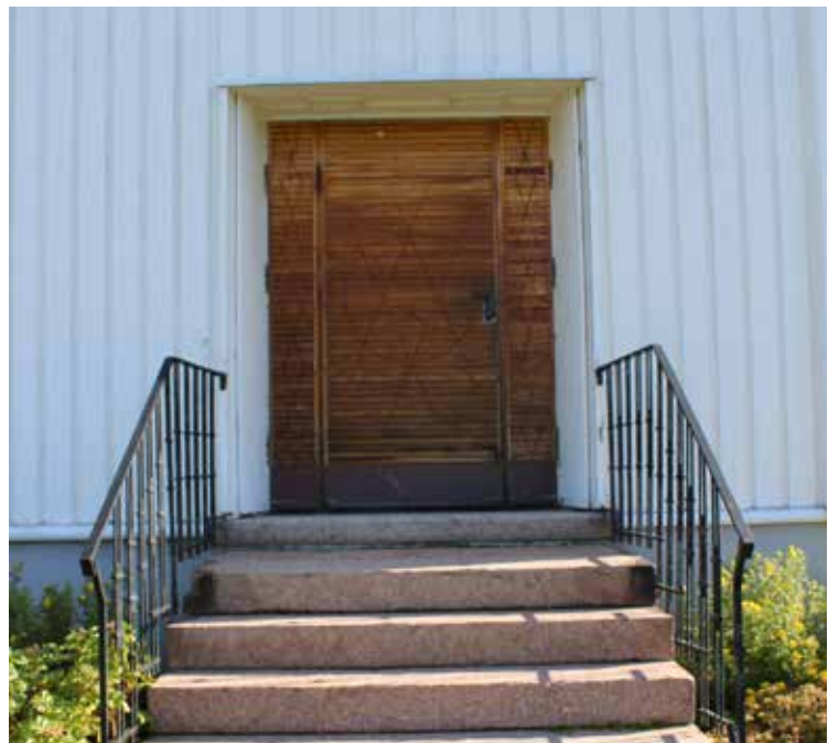
Enger kirke (til venstre) fra 1875 er en langkirke oppført i henholdt til periodens standard arkitekttegning for kirkebygg. Restaureringen i funksisstil på 1950-tallet, jf. inngangsportalen på fotoet, medfører at kirken fremstår som særegen.
