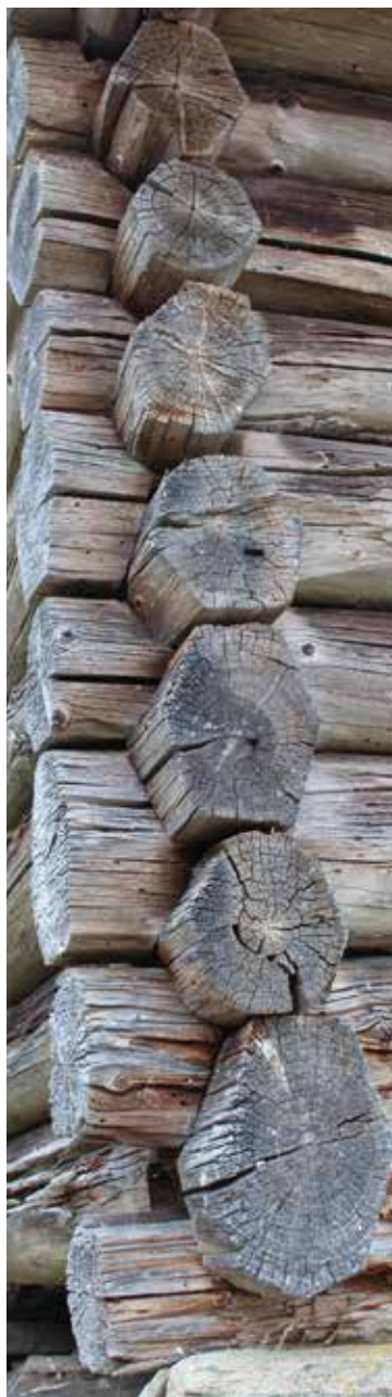
Amundstuen øvre med utvendig loftstrapp (over). Detalj av novene på låven (venstre)
