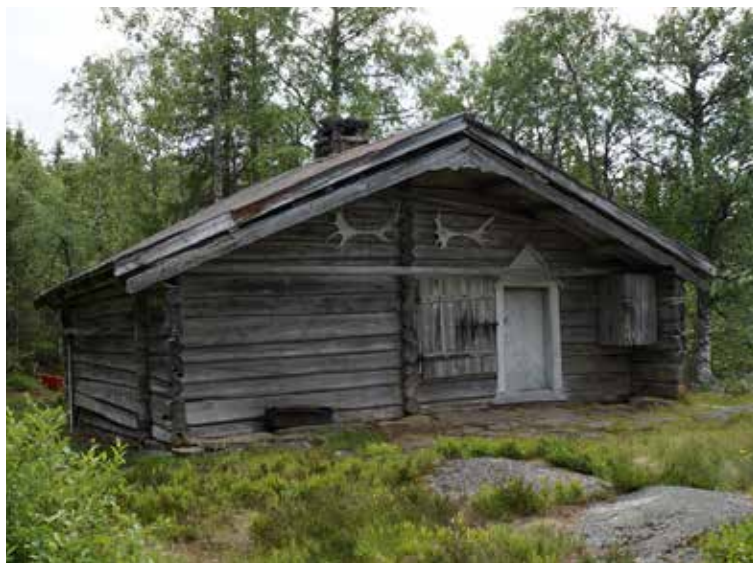
Fiskehytta Myrebua ved Selsjøen er blandt de eldste eksisterende bygningene i Lomsdalsvassdraget. Foto Dag Lindbråten.
