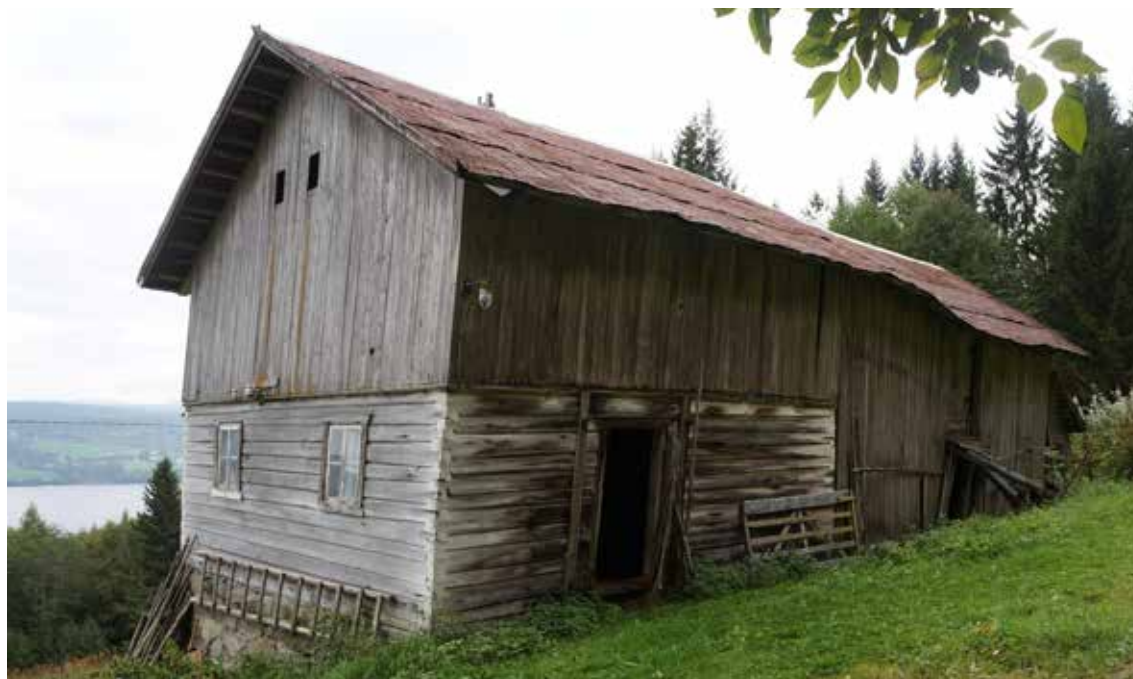
Låve fra ca 1900 med fjøs i kamlaft og forlåve i grovt bindingsverk. Tekket med blekk av utban- kede tønner. Foto Dag Lindbråten
