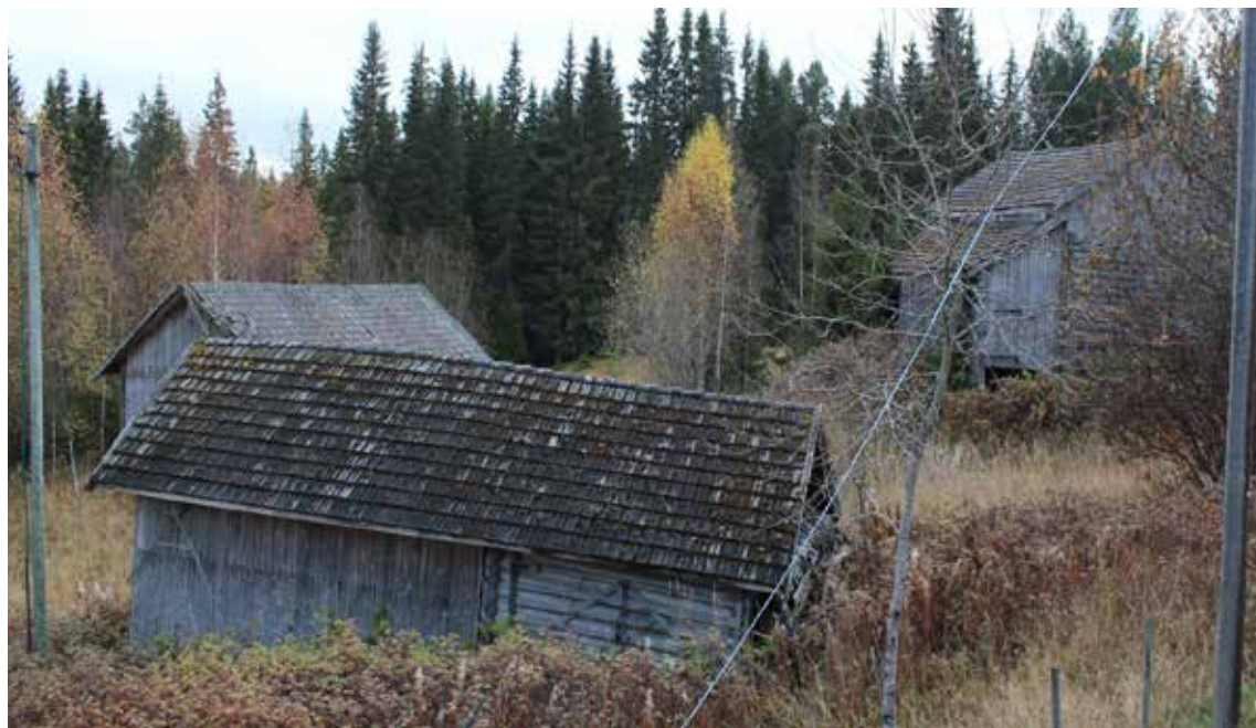
Oversikt av bygningsmiljøet med uthus (nærmest), våningshus og låve.
