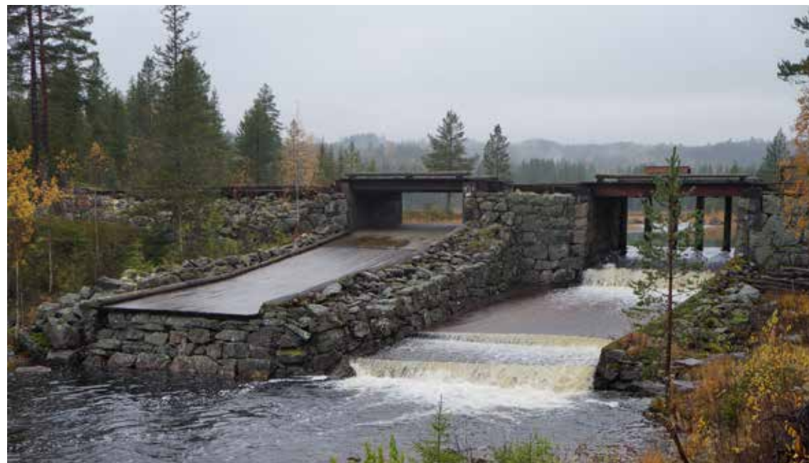
Vesle Sandungsdammen bygget mellom 1875 - 1880. Treverket ble restaurert i 1966, to år før brøtningen opphørte. Sandungsdammen ble ytterligere restaurert i 1994. Foto Dag Lindbråten.
