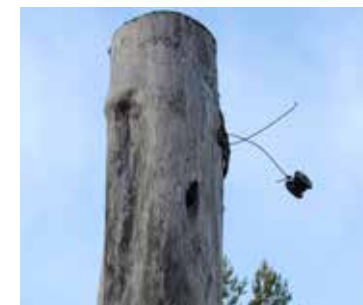
Porselensisolator fra telefonforbindelsen til Askvikfløyta.
