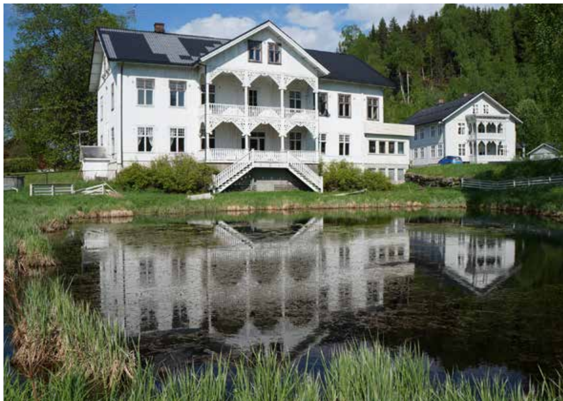
Odnes hotell med verneverdig dam og Jense-butikken til høyre. Utbygget på hotellet fra 1960 tallet er revet etter at bildet ble tatt i 2016 som del av tilbakeføring til opprinnelig sveitsertil. Foto Dag Lindbråten.
