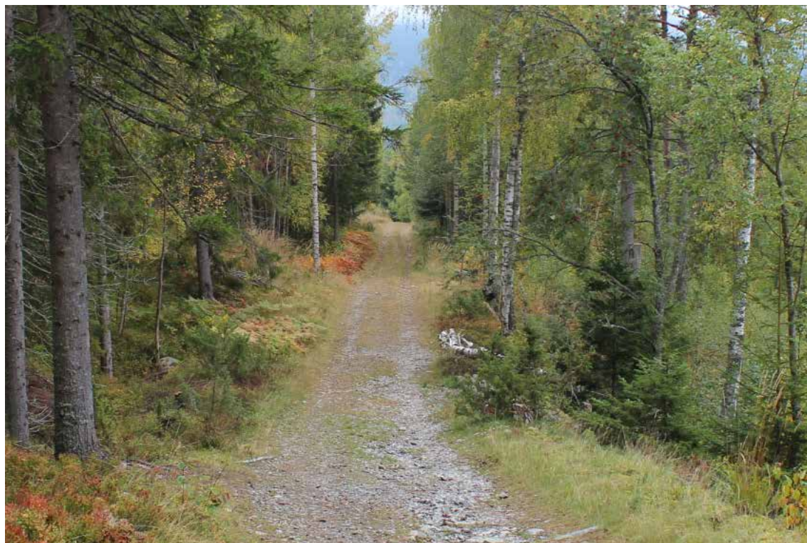
Bergenske hovedveg over Hornskleiva ble bygget i perioden 1801 - 1811. Vegene mellom Christiania og Bergen er bygget etter det franske prinsipp med lange rette strekk og markerte knekkpunkter slik bildet viser. Bevarte "fossile" deler viser at det franske prinsipp er konsekvent gjennom Land. Vegene over Hornskleiva er ca 6 meter bred.
